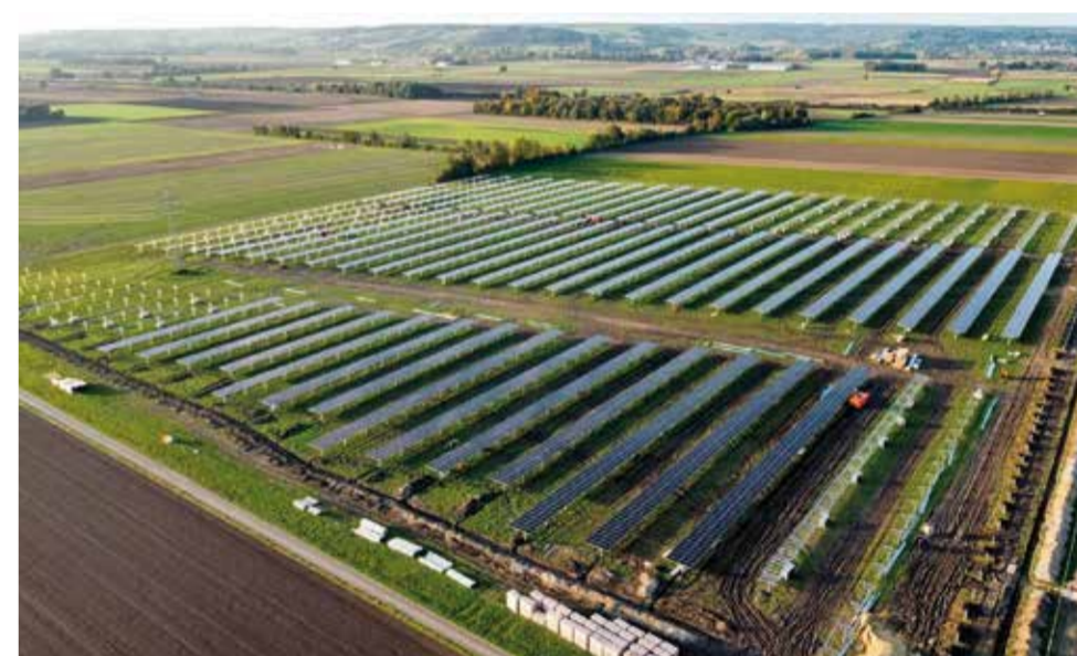
Agrivoltaická elektrárna společnosti Greenbuddies v obci Oberdorf am Lech je před dokončením.
