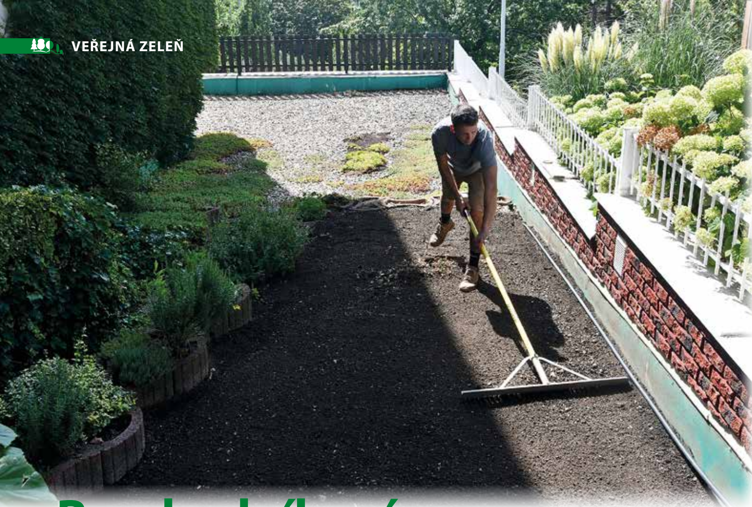
Urovnání povrchu půdy před rozhozem substrátu
