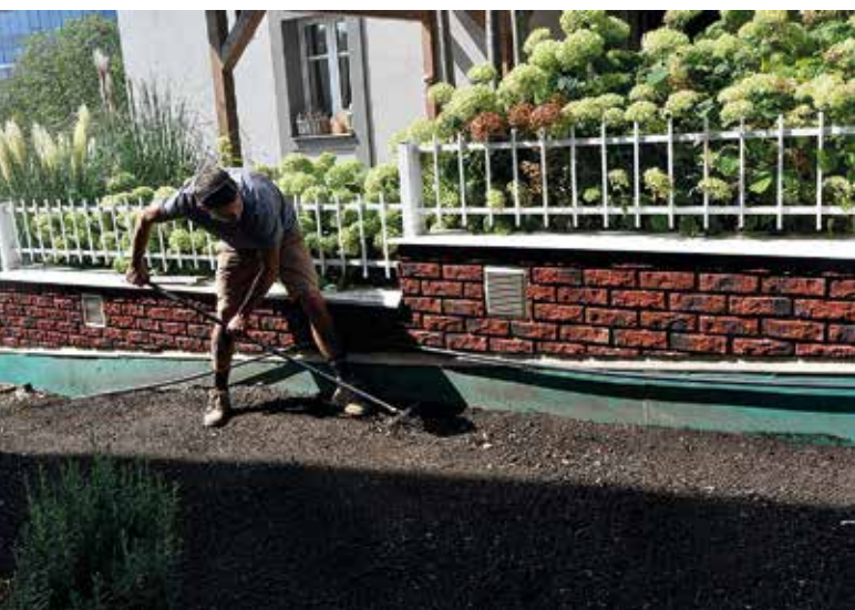
Urovnání povrchu půdy před rozhozem substrátu
